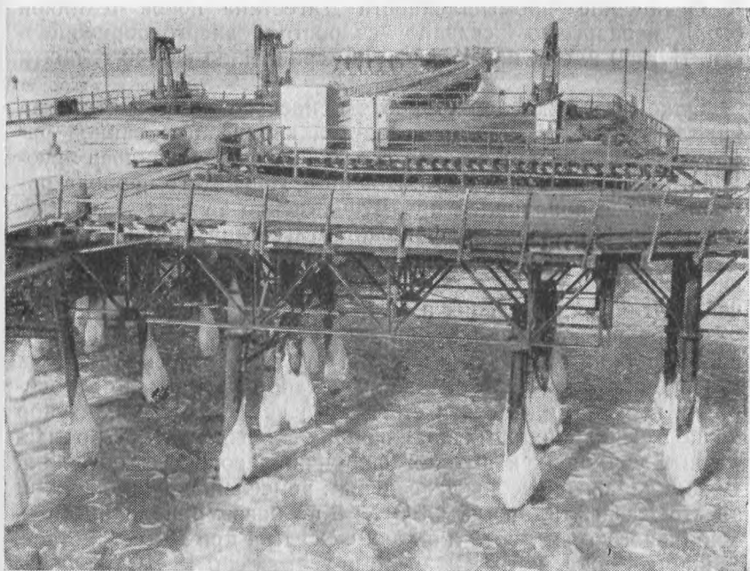
Эстакада Избербашского нефтепромысла
