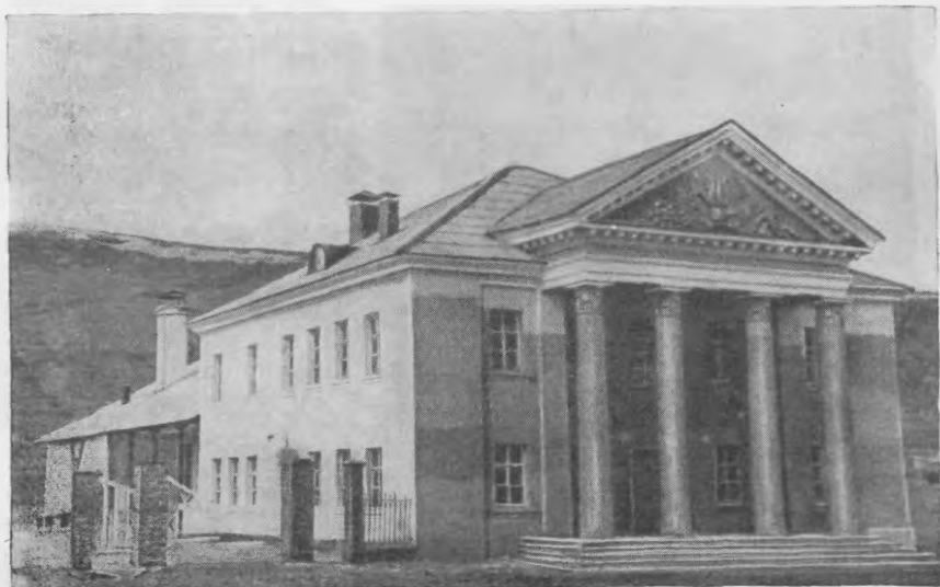
Рис. 81. Здание клуба строителей Сулакгэса в сел. Бавтугай (фото Ю. Шевелева)
