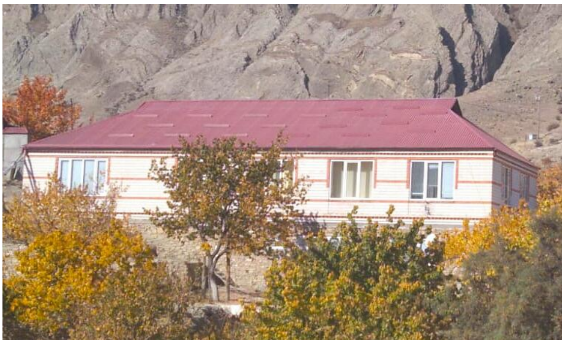
Дом Омара Омарова в с. Куппа Левашинского района. Построен в 2003 г.
