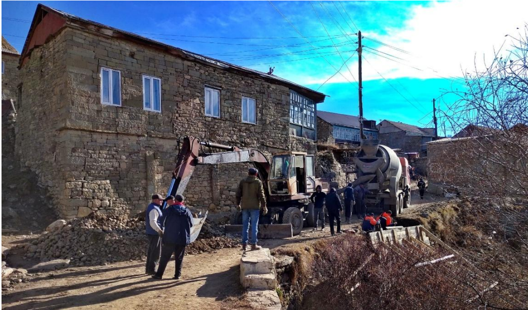
Ремонт дороги в с. Цовкра-1 Кулинского района. Фото Шамхала Хизриева.
