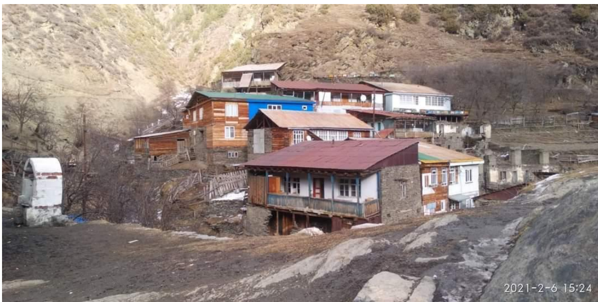
Новый квартал с. Бежта Цунтинского района.
