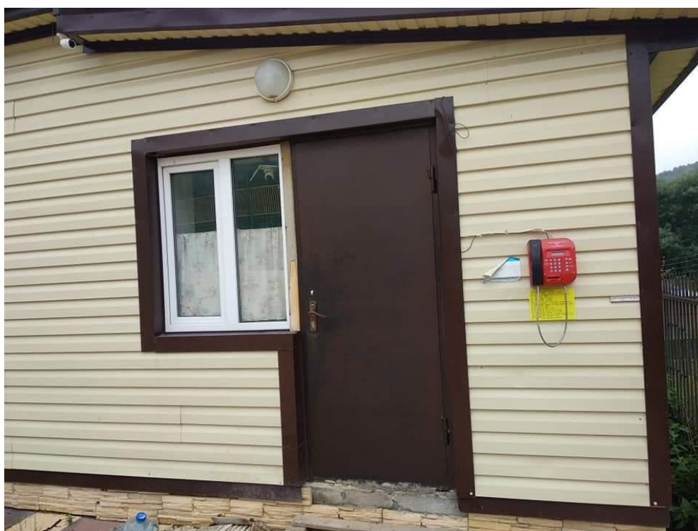
Таксофон на крыле здания новой школы с. Джули Табасаранского района. Фото 2020 г.
