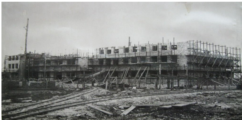
Строительство школы № 2. Фото 1939 г.
