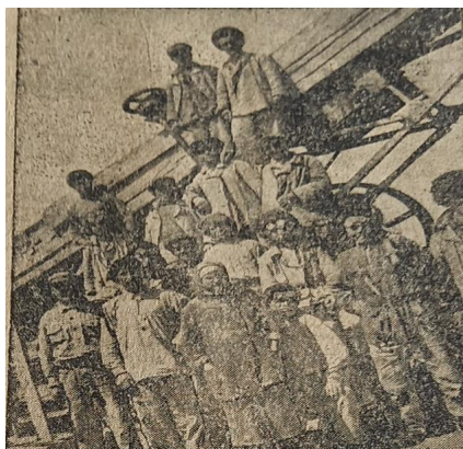
Бригада бетонщиков-стахановцев М.М. Хуразова. 1935 г.
