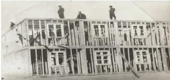
Строительство первых камышитовых барачков. 1933 г.
