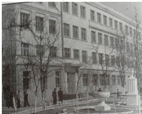
2-й корпус эвакогоспиталя № 4654 (средняя школа № 1)
