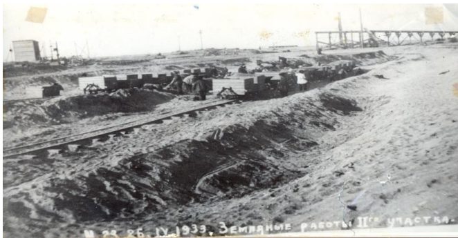
Кладка фундамента цехов завода № 182. Земляные работы на 2-м участке. 26.04.1933 г.
