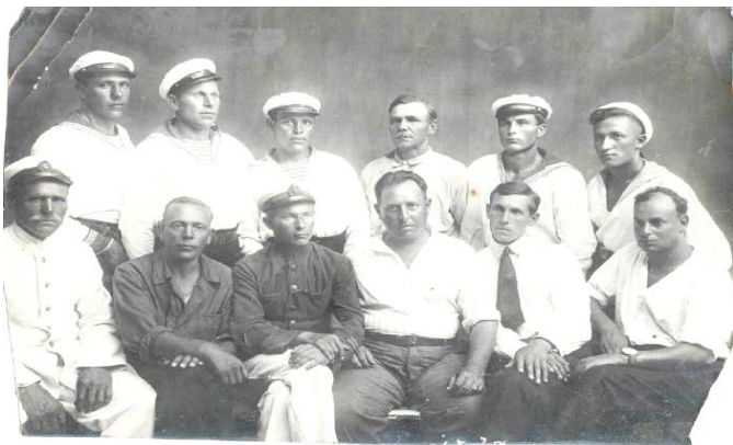
Группа руководителей строительства здания в море (цех № 8). Май 1935 – август 1936 гг.
