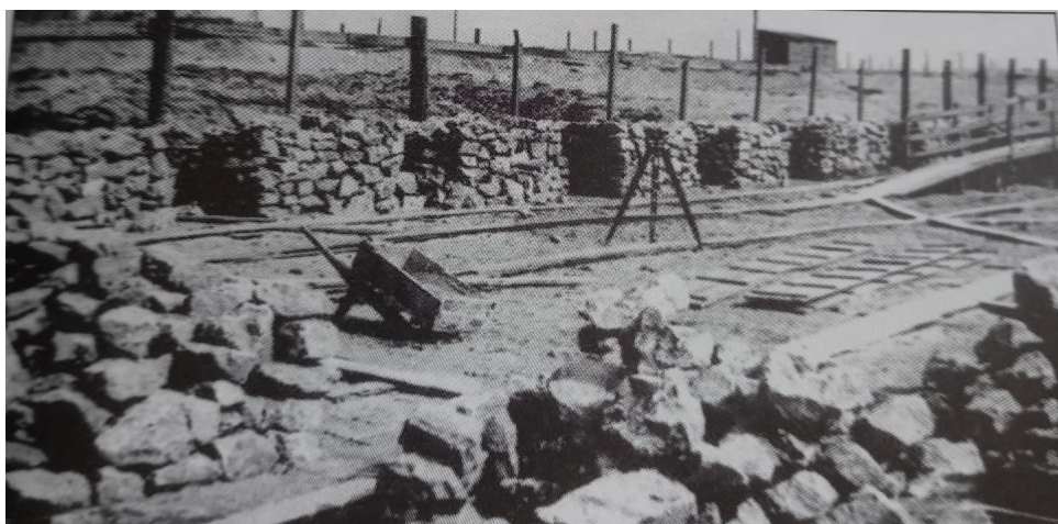
Закладка фундамента здания для будущего женского общежития по ул. Мира.
