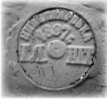
Геодезический знак на здании вокзала
