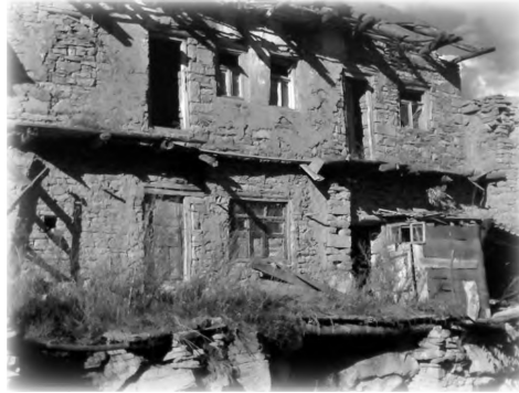
Двухэтажный дом с террасой
