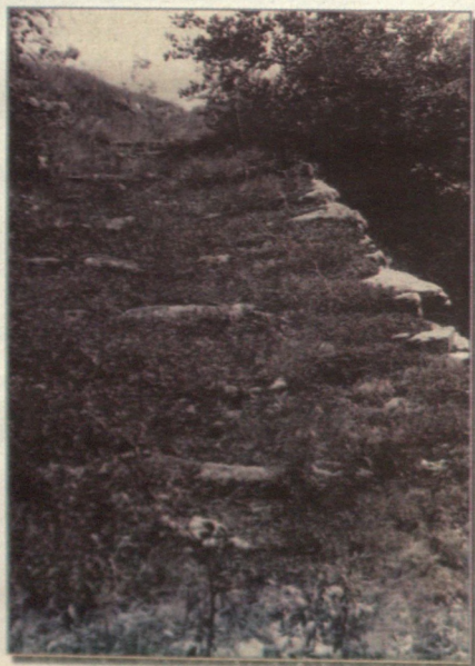
Рис. 18. Вымостка полотна дороги.
