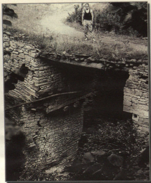
Рис. 23. Мост через реку Буган.
