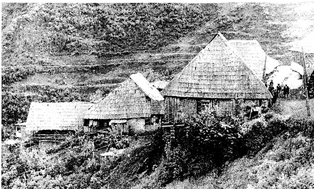
Дома с драночным покрытием
