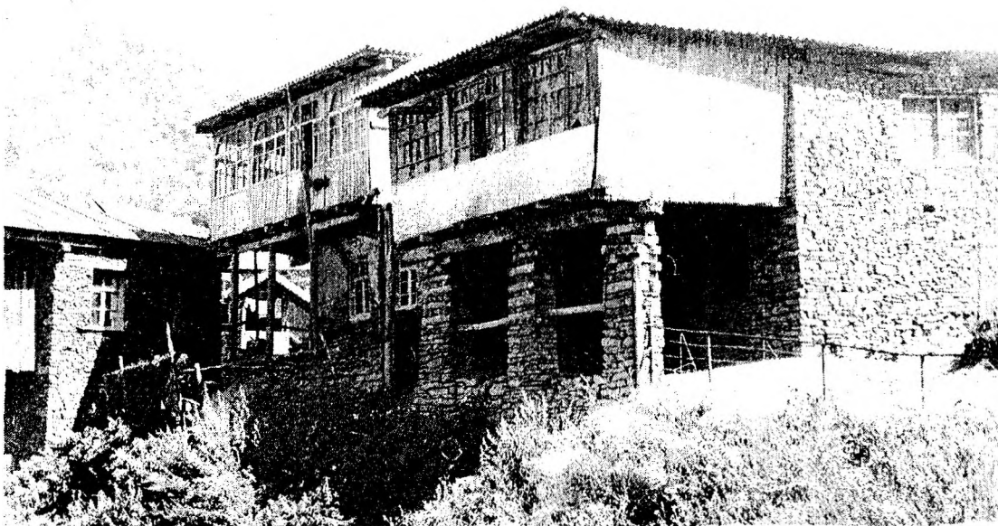
Деревянная пристройка на столбах
