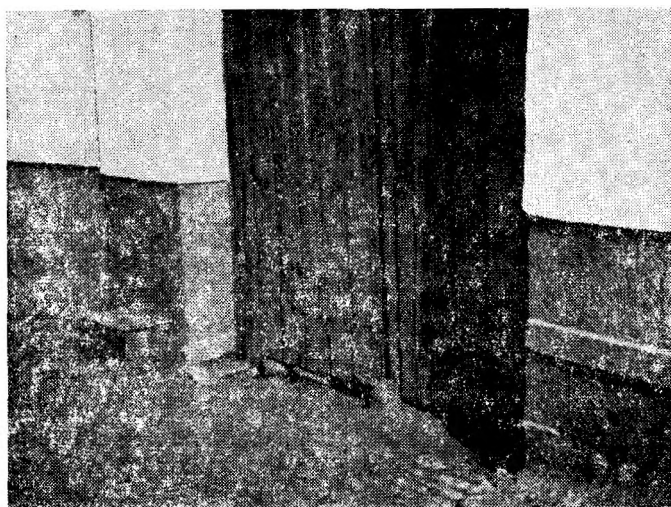
Рис. 12. Цокольная часть стен.
