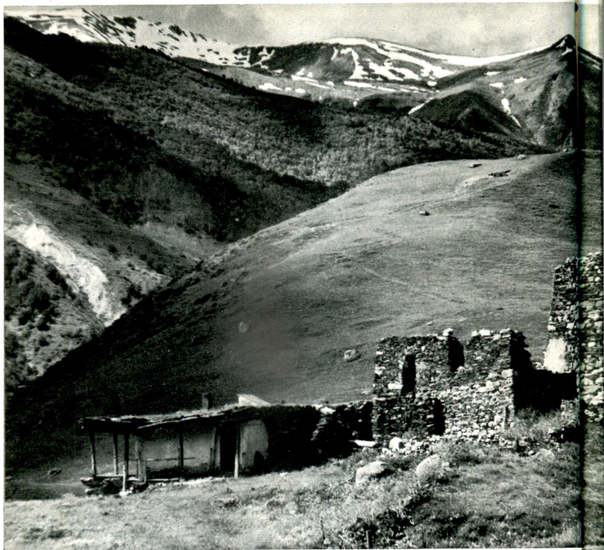
191. Обособленный жилой комплекс в Северной Осетии: развалины боевой башни, жилой башни, оборонительной стены
