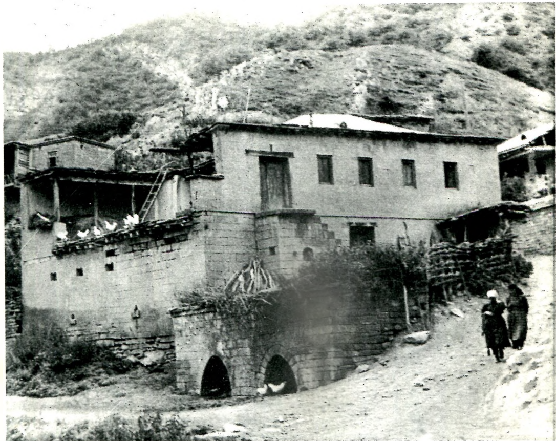
72. Дом в с. Шиляги, построенный в начале XX в.
