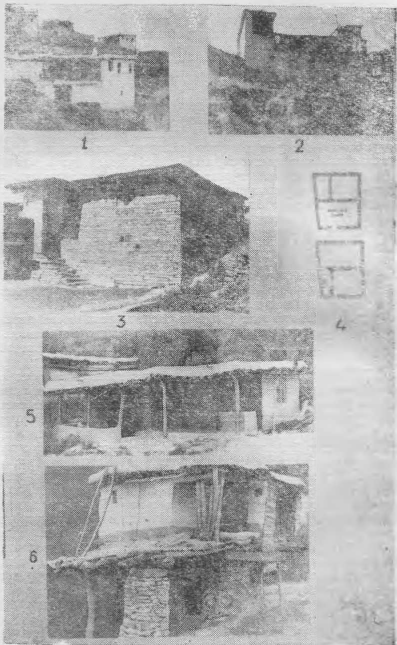
Рис. VIII. Предгорные старые дома: 1 — дом с закрытым двором с. Када, — 2 — дом из тесаного камня с. Жигия, 3 — дом с закрытым двором с брусьями в кладке с. Дурегги, 4 — схема дома закрытого типа с. Гублен, 5 — одноэтажное жилище с. Кадар, 6 — дом с открытым двором с. Газия.
