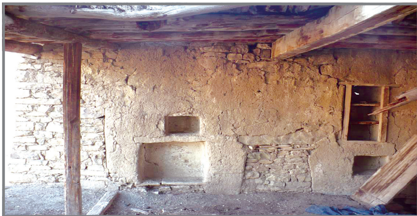
Рис. 11. Заложенный камнями проем в соседнее помещение. Кудутль. Фото автора. 2008 г.
