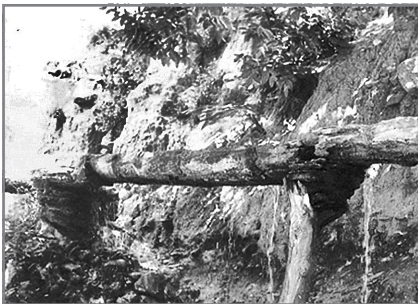
Рис. 33. Деревянные акведуки в гимринских садах. Фото автора. 2005 г.
