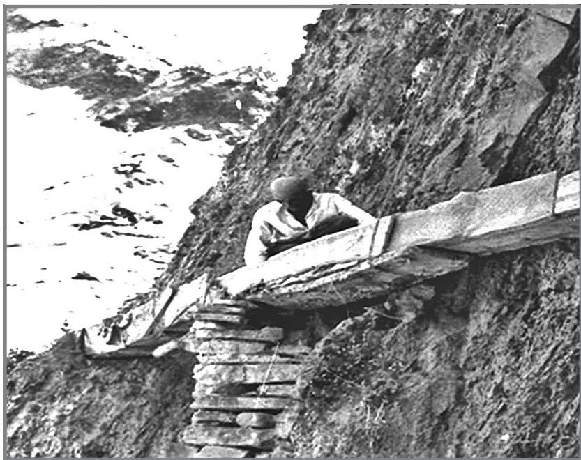
Рис. 35. Ремонт водопровода. Корода. Фото автора. 1967 г.
