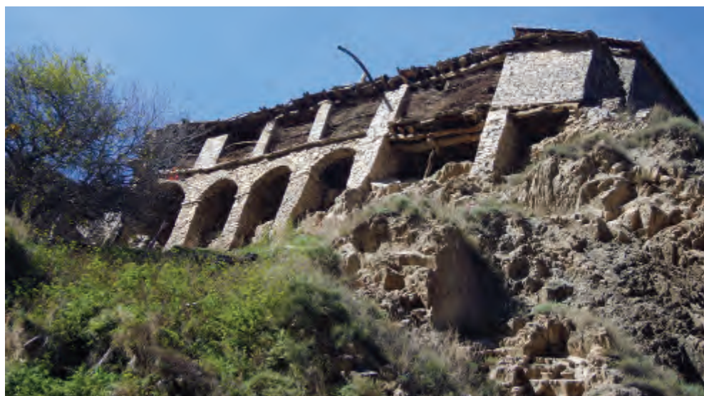
Подпорные стенки жилого строения в квартале Обонуб.
